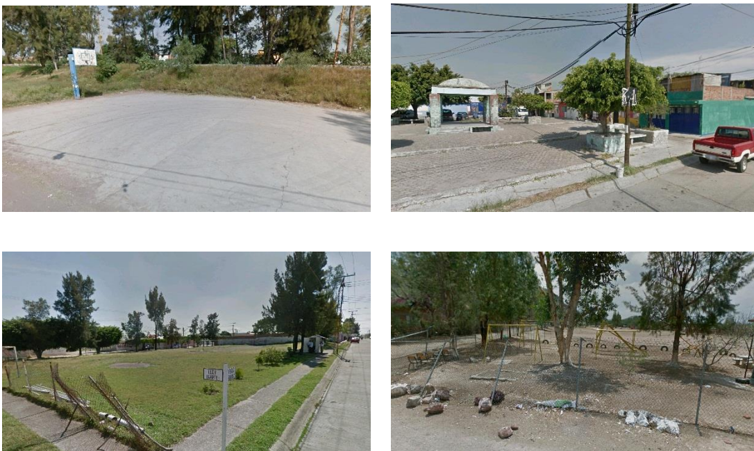
Fotografía 13-21. Abandono y deterioro de espacios públicos, 2018
